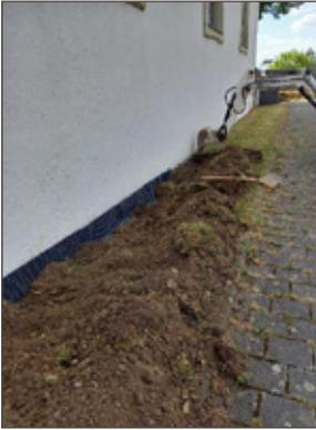
An der **nördlichen Kirchenmauer** und der anschließenden Friedhofsmauer wurde eine Noppenbahn eingelegt und das Erdreich mit Gefälle Richtung Weg abgezogen. Nun ist diese Wand/Mauer gegen Feuchtigkeit durchgehend geschützt. Das teilweise im Erdreich verdeckte Wappen wurde durch Rundbögen mit Kiesbett neu gefasst und ist damit nicht nur geschützt, sondern wird auch hervorgehoben.
